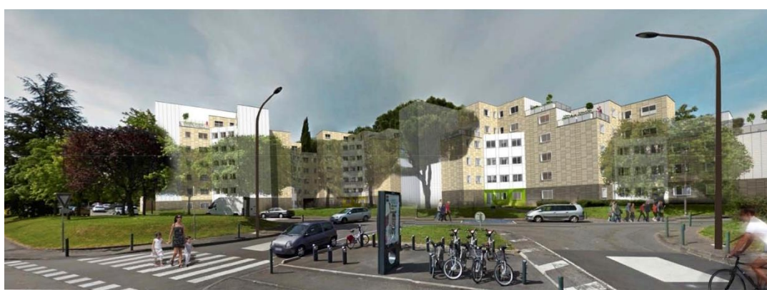
Vue après travaux
